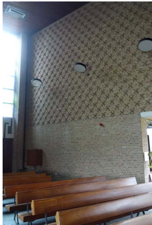
Siermetselwerk in de zijwand (foto MAB, 2025)
