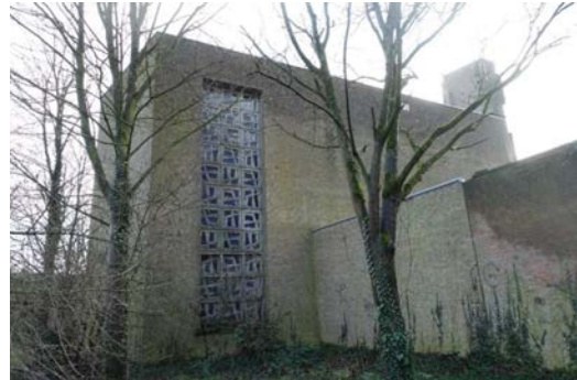
Westelijke gevel van de kerkzaal met de vensterstrook met 33 glas-in-betonstenen en rechts de tuinmuur (foto MAB, 2025)
