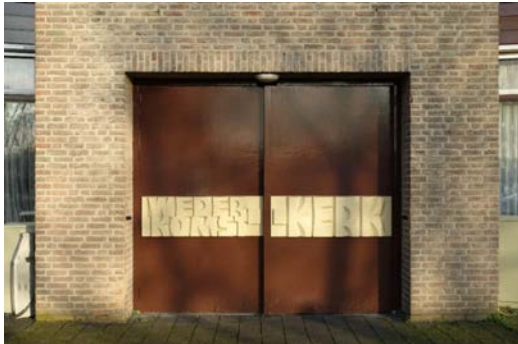
De centrale entree in de toren (foto MAB, 2025)
